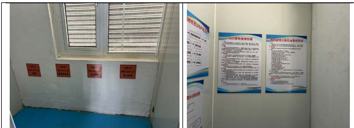
危险废物贮存库内部
